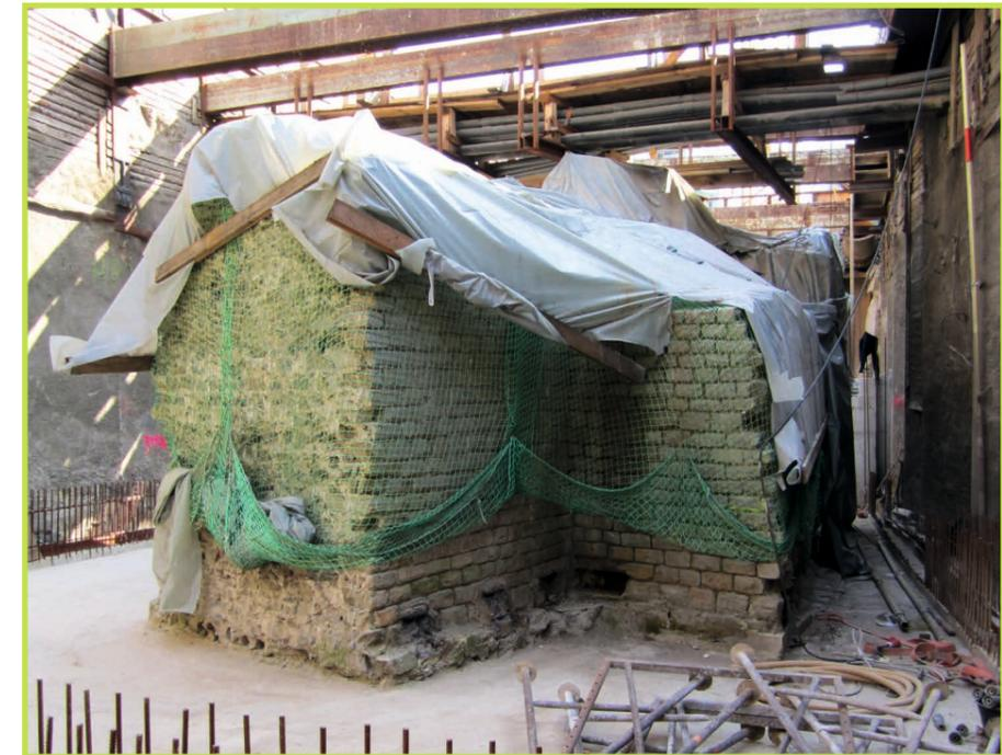
Nach der Fertigstellung der Tunnelröhre sitzt jetzt die Stadtmauer nicht mehr auf ihrem Fundament, sondern auf der Tunnel-Decke (siehe Abbildung oben).
