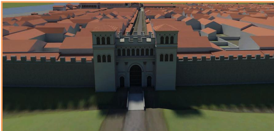
Wenn man durch den Torbogen geht und zurückschaut, blickt man auf die Außenseite (Feldseite) der Tor-Ruine (siehe Seite 18, digitale Rekonstruktion des Nordtors). Verzierungen des Bauwerks sind im unteren Bereich noch gut erkennbar: Es sind flache Wandpfeiler (Pilaster), die wie eine Säule in Basis, Schaft und Kapitell gegliedert sind.
