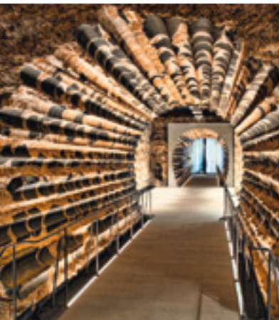
Bohrung durch das 7 bzw. 11 Meter dicke Fundament des Südturmes | © Dombauarchiv Köln, M. Welschenbach
