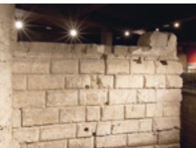
Nordseite des Ubiermonuments Foto: © RGM/RBA Köln, A. Wegner
