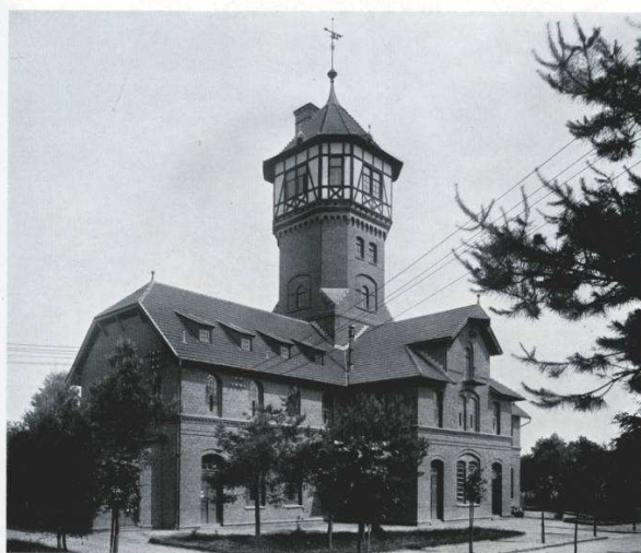
Provinzial-Heil- und -Pflegeanstalt Galkhausen. Kessel- und Maschinenhaus.
