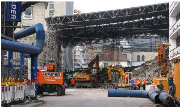
Einsturzstelle am Waidmarkt 17.03.09
