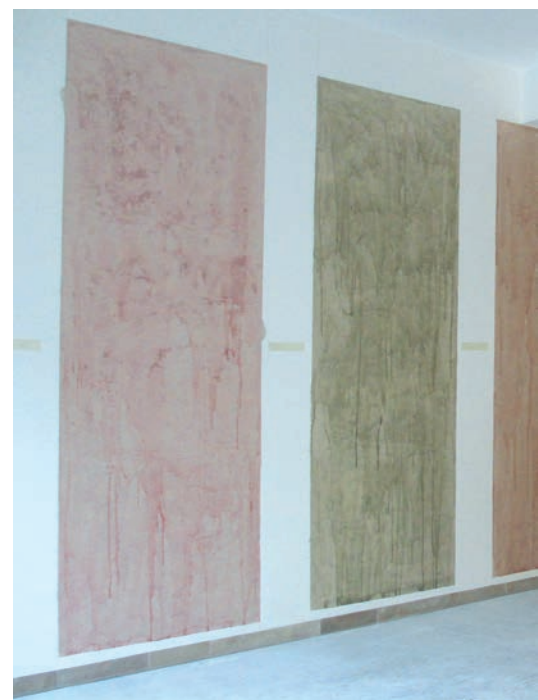
Musterbahnen mit unterschiedlichen Farbtönen und Untergründen – am 9. Oktober 2012
