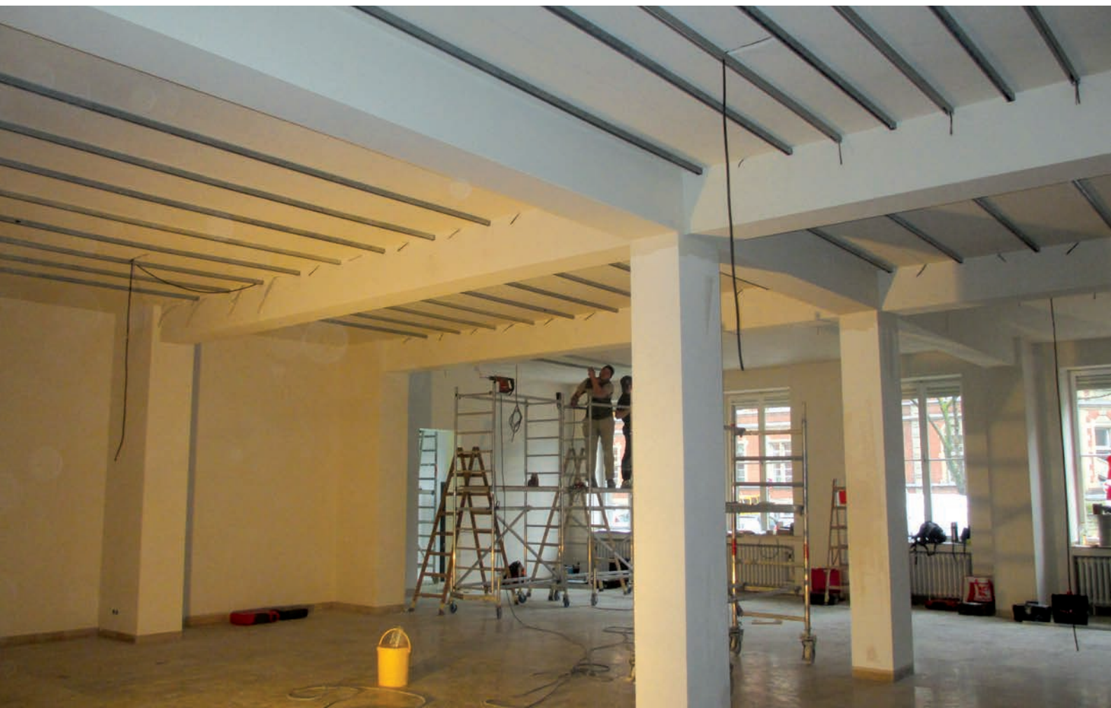
Montage der Licht- und Hängeschienen – am 27. November 2012.
