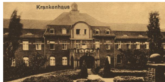
Jüdisches Krankenhaus, um 1920
